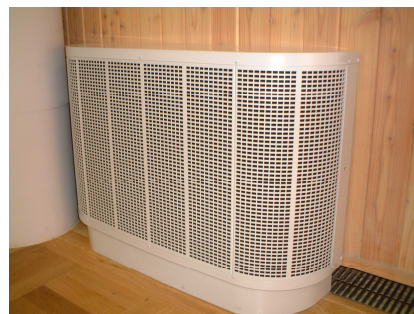
長池ネイチャーセンター(左上)では、外気を通年15度の地中に取り込み、室内の吹出し口(右上)から冷風がでており、真夏でもクーラー要らずだった。
