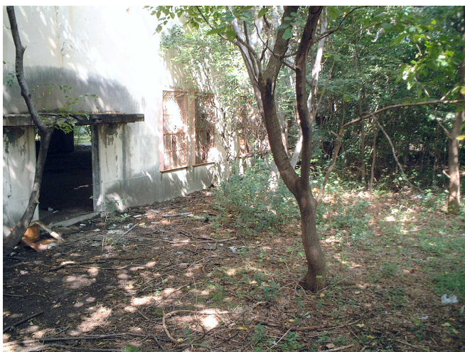
フェンスで囲われた基地跡地。 荒廃状態で半世紀も放置されたまま。
