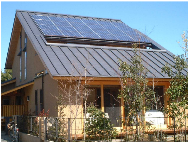
市内ではまだまだ珍しい太陽光パネルを設置した家 左: 是政のHさん宅。 右: 栄町のAさん宅。
