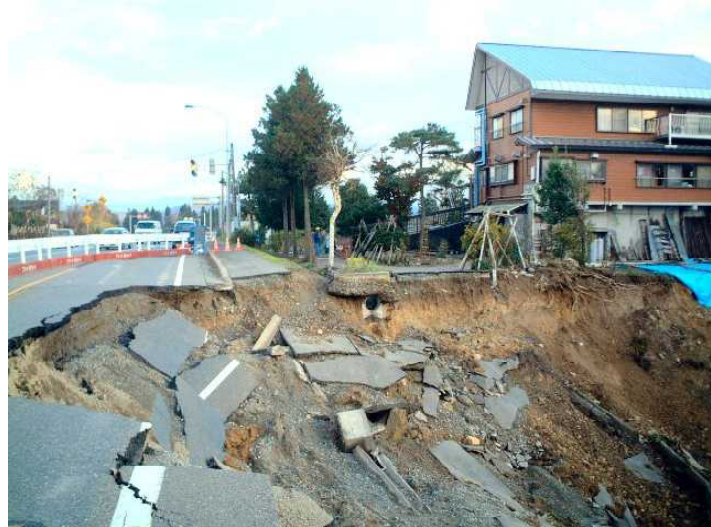
大きくダメージを受けた国道171号線と信濃川沿いの民家／小千谷市塩殿地区
