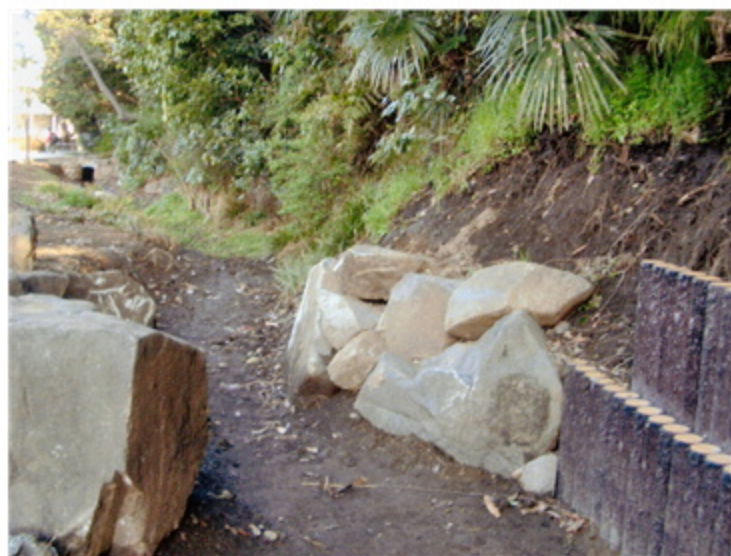
既設水路と素掘部(岩の湧水)との接続工事
