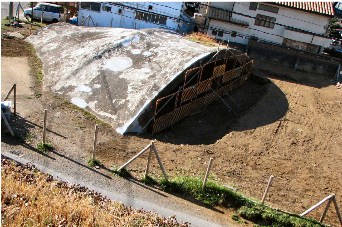
戦跡文化財として保存が決まった白糸台掩体壕(白糸台2丁目、甲州街道西武線踏線橋脇)と府中市が買い上げた公園予定用地の一部。左上のクルマと比べると大きさがよくわかる。当時、セスナ機ほどの大きさの戦闘機が、米軍機の目を逃れるように、ここに格納されていた。(三月八日、甲州街道西武線踏線橋から撮影)
