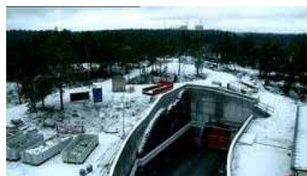
建設中の核廃棄物最終処分場オンカロの地下への入口(フィンランド)
