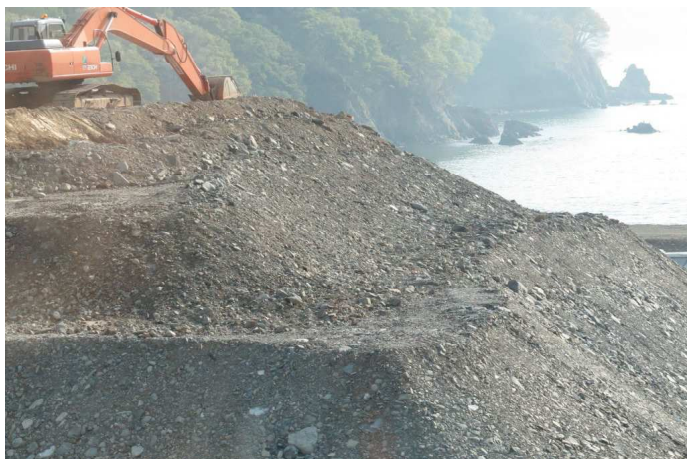
住宅建設のため、山を削っての盛土工事
