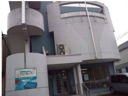
市民共同発電所1号機の建物
