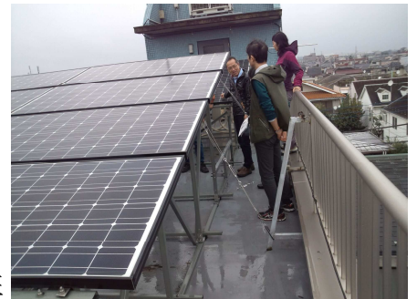
太陽光パネルを見学
