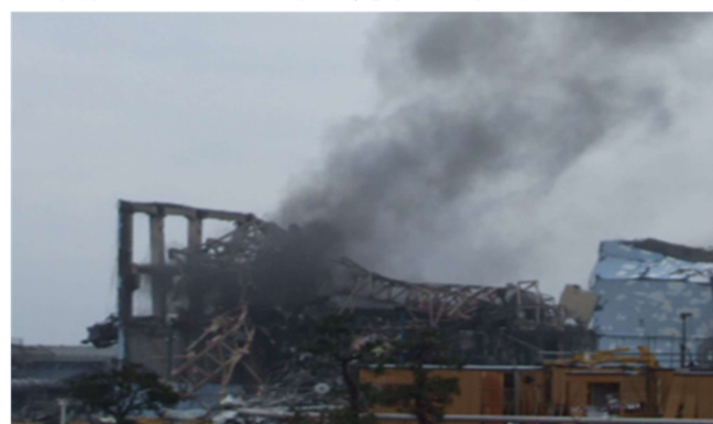
原発事故直後の福島原子力発電所3号機燃料池(エネルギー庁)
