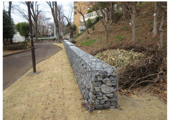
④蛇籠と本宿町緑地中腹の竹杭等 ⑤真横からみた蛇籠と手前のバイオネット
